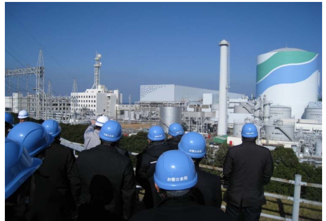
川内原子力発電所(川内市)
