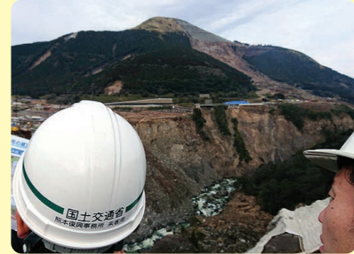
大規模な斜面崩落で寸断された 阿蘇大橋の架け替え工事現場
