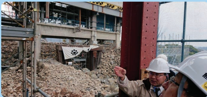
熊本城、飯田丸五階櫓と天守閣の復旧工事現場
