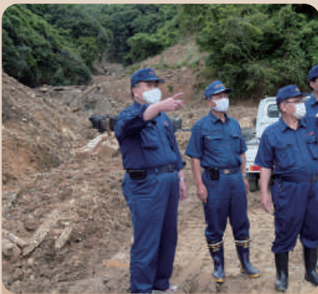
津奈木町福浜のがけ崩れ現場
