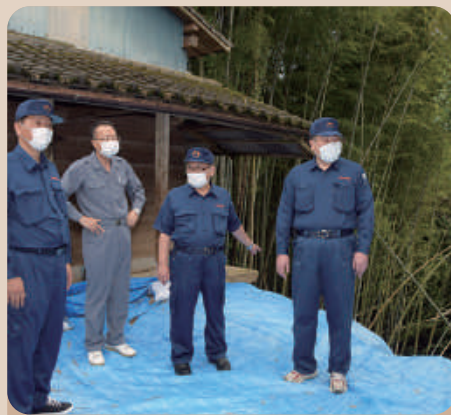
南関町西豊永の法面崩落現場
