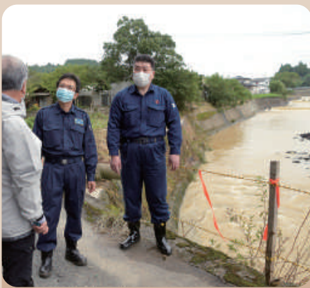
南関町高久野の河川崩落現場
