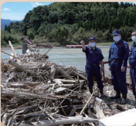
相良村くま川鉄道の鉄橋崩落現場
