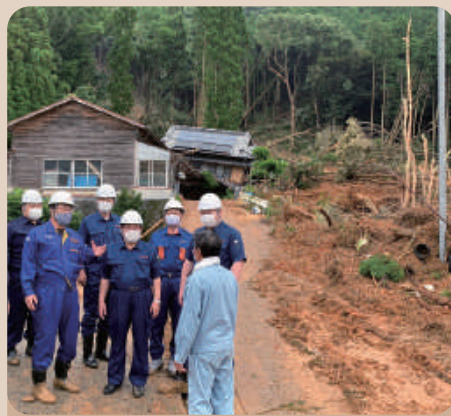
芦北町田川のがけ崩れ現場
