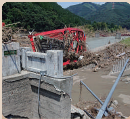
球磨村の相良橋崩落現場
