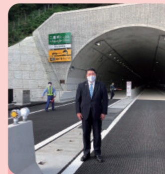
北側復旧ルートが開通
