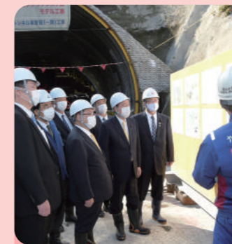
国道57号 滝室坂トンネル工事現場
