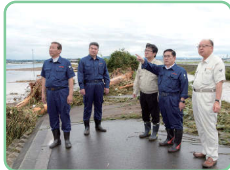
豪雨被害の被災地を視察
