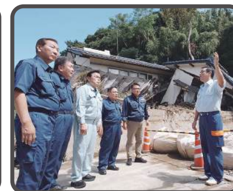
甲佐町のがけ崩れ現場で現場視察
